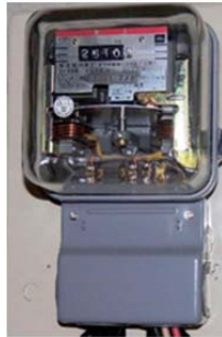
図 3 回転円盤型電力量計
