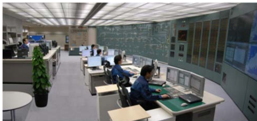
図 4 中央給電指令所の様子 （画像提供：東京電力株式会社）
