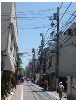
(a) 街中 (道の端に電柱が並んでいる)
