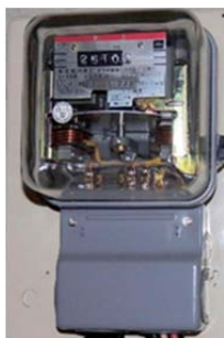
図 3 回転円盤型電力量計
