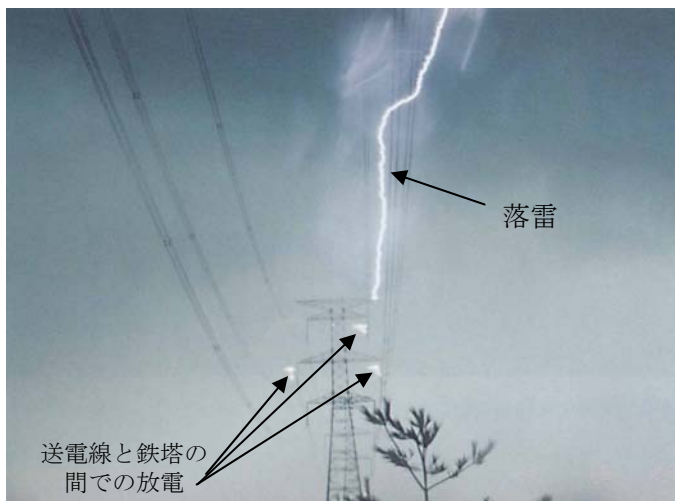
図 33 送電鉄塔への雷撃で放電が起こった写真 (画像提供：北陸電力株式会社)
